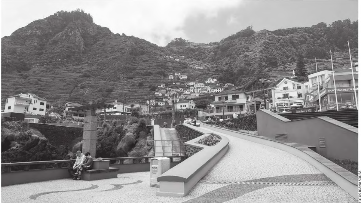
Áreas de intervenção da autarquia do Porto Moniz, ao nível do apoio à população e obra física, são bastante vastas.
