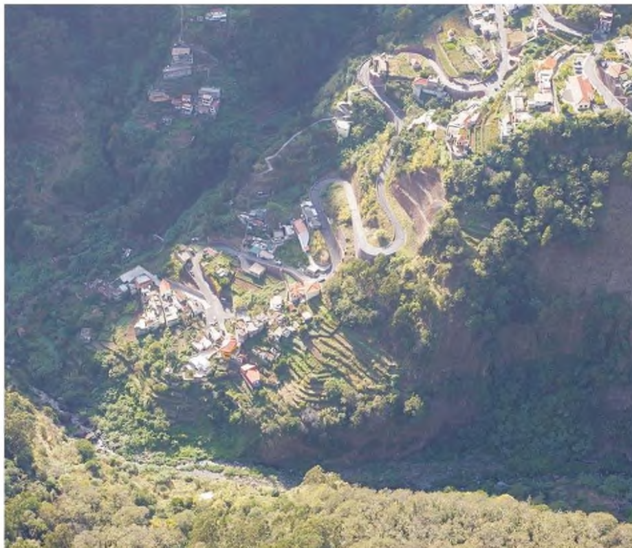
Redes de distribuição de água potável e de drenagem das águas residuais na freguesia estão a ser intervenionadas.
