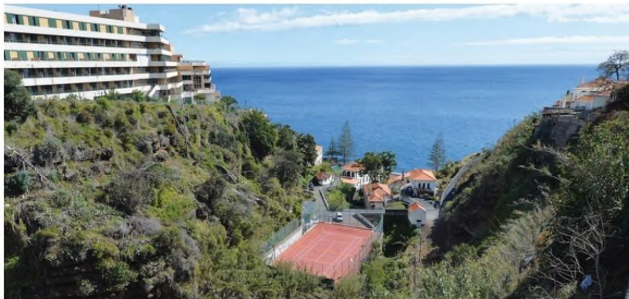
A obra da ETAR do Funchal está orçada em 12,4 milhões de euros.
