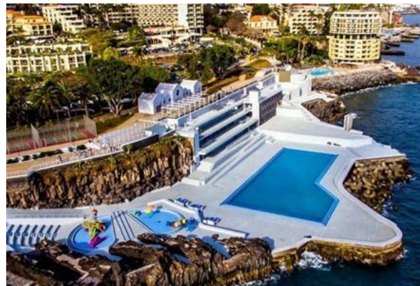
Figura 13 Remodelação das Piscinas do Lido
