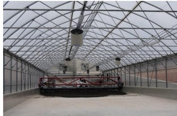
Figura 9 Sistema de Tratamento de Lamas da ETAR do Porto Santo
