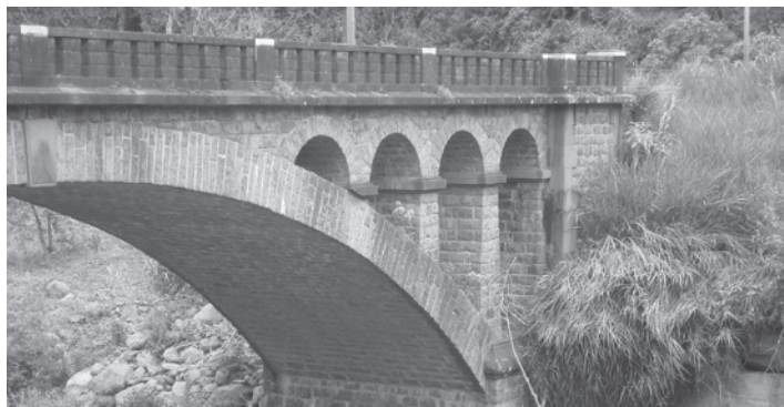
Ponte São Jorge - Santana
