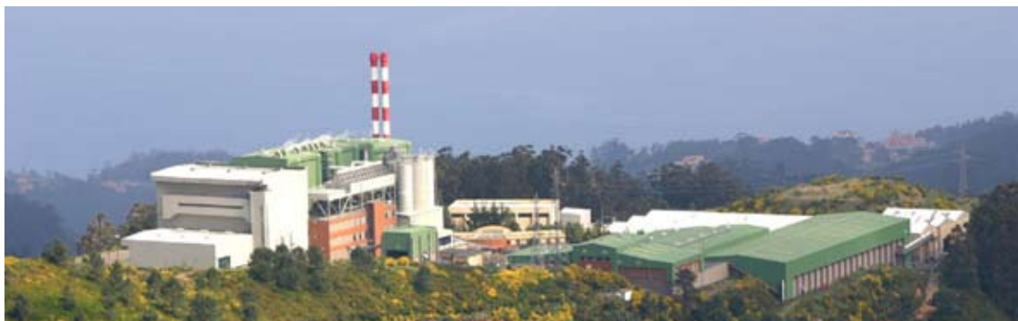
Estação de Tratamento de Resíduos Sólidos da Meia Serra (remodelada e ampliada), operacional desde Dezembro de 2003.
