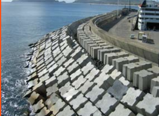
Vista parcial dos 4.000 blocos “anfíferes” de protecção do segmento-sul do molhe exterior, colocados no âmbito da empreitada da “Grande Reparação do Molhe Principal”.
