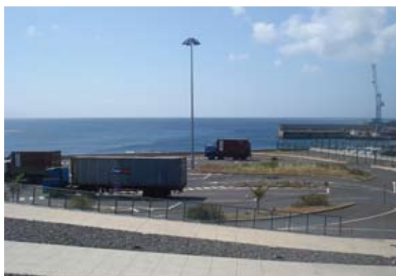
Ampliação (20.800m 2 ) para Nascente do Terrapleno do Porto do Caniçal para estacionamento de viaturas pesadas e cargas especiais.
