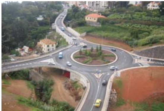
Rotunda da Quinta Magnólia à entrada do Túnel da Pontinha, construída no âmbito do Projecto em apreço.
