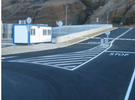
Acessos ao porto construídos no âmbito da empreitada “Grande Reparação do Molhe Principal”.
