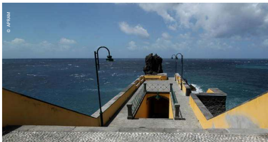
Requalificação e reabilitação cais ponta de sol.
