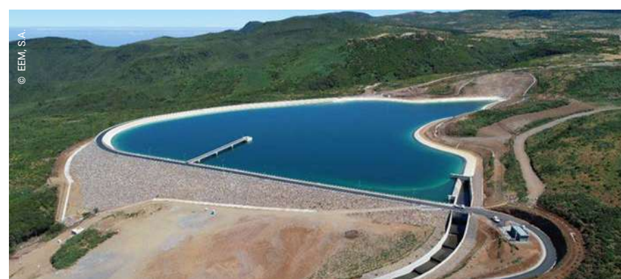
Ampliação do Aproveitamento Hidroelétrico da Calheta. Copyright: EEM, S.A.
